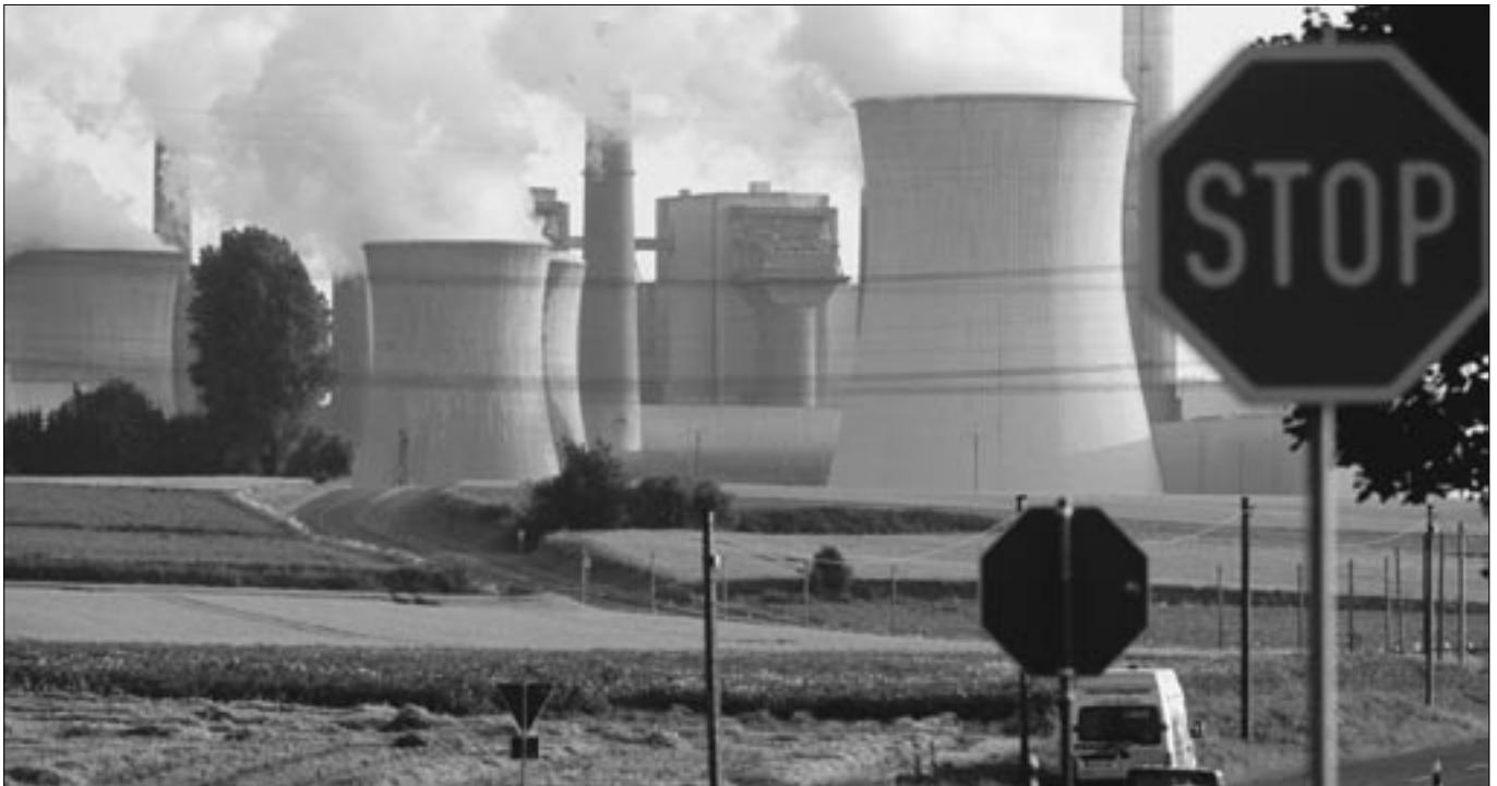
Das Kohlekraftwerk Neurath bei Köln: Mit jährlich über 30 Millionen Tonnen CO 2 -Ausstoß wird es die größte Dreckschleuder Europas. Foto: B. Arnold / Greenpeace
